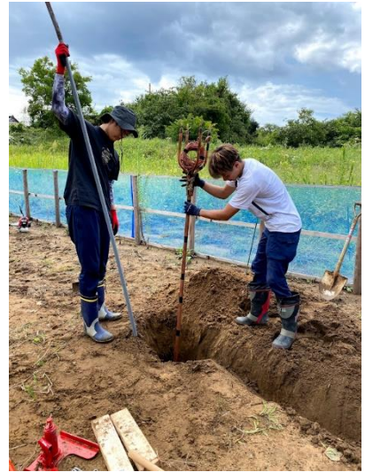
Photo.8 HP 埋設の様子
