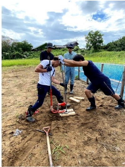
Photo.7 掘削の様子(杭抜き)
