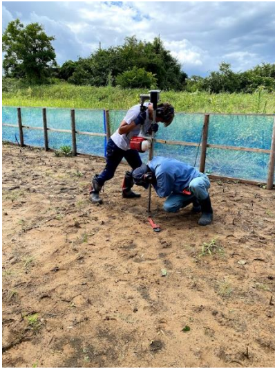
Photo.6 掘削の様子(杭打ち)
